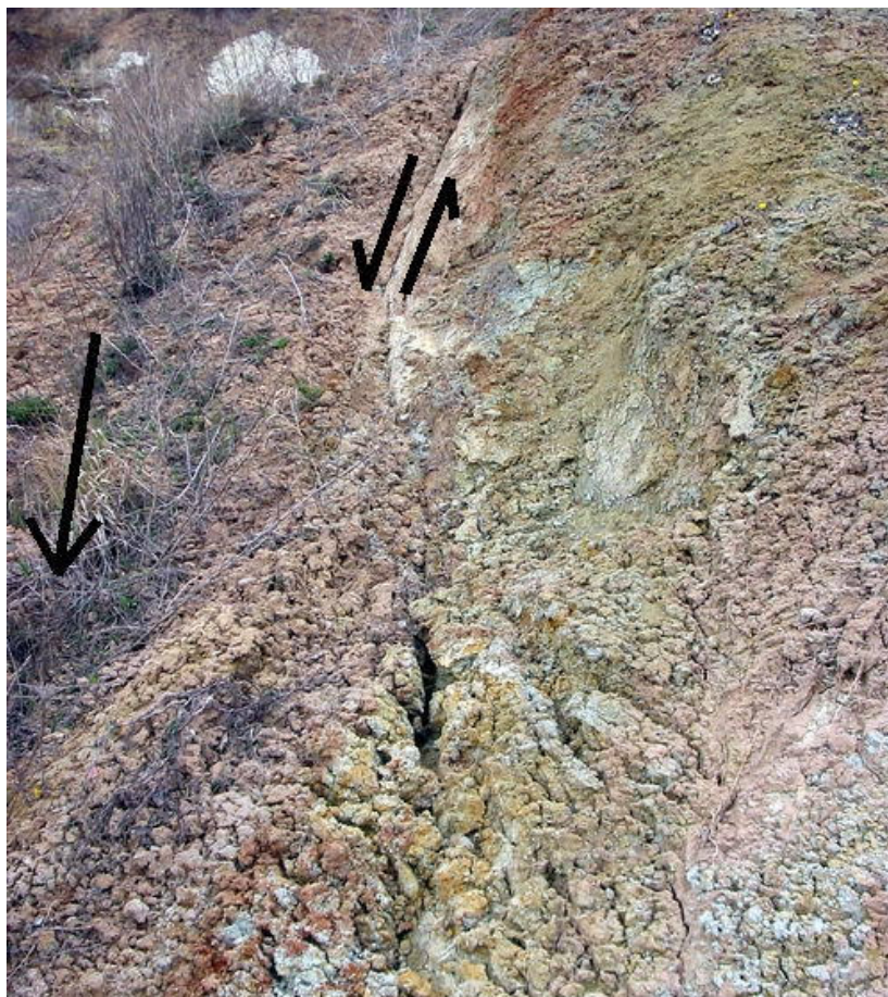
Fig. 10. Boczna powierzchnia poślizgu; po prawej mamy grunt stabilny, natomiast po lewej przesuwaną się masę skał osuwiska.
