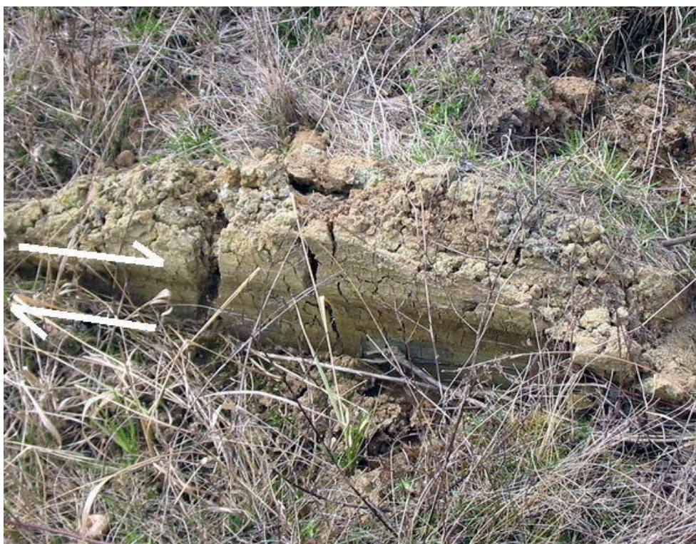
Fig. 11. Boczna powierzchnia poślizgu – widoczna gładka powierzchnia łu z lekkimi bruzdami zgodnymi z kierunkiem ruchu osuwiska.
